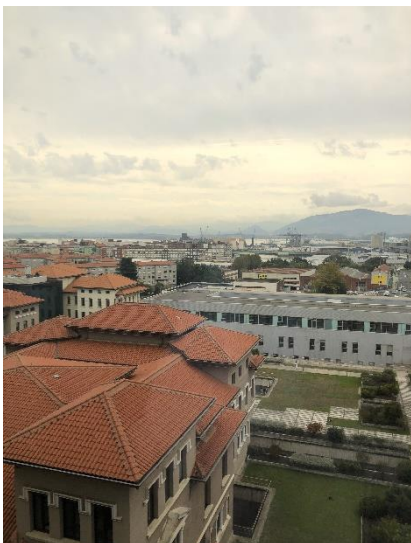
Blick auf das Krankenhaus Gelände
