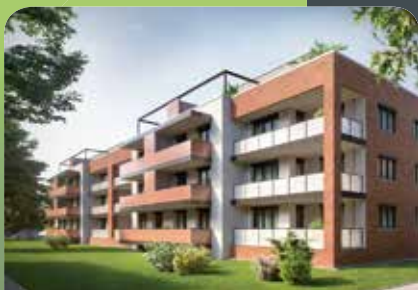
Zwei Wohnhäuser mit 26 Wohnungen in Misburg
