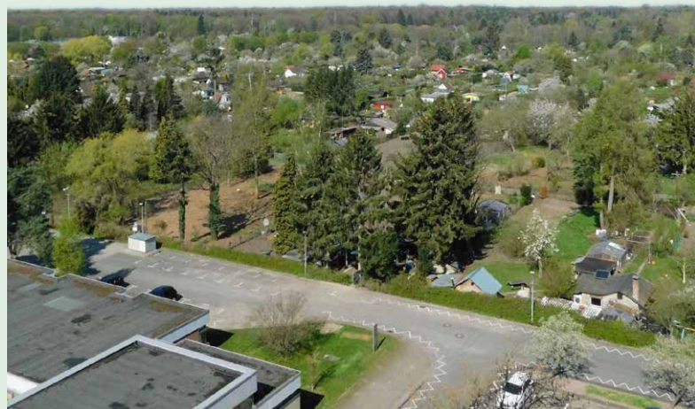
Hier sollen im August Bagger und Planiertrappen das MHH-Baufeld herrichten
